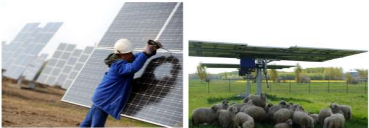
400 kWp teljesítményű, hálózatra kapcsolódó fotovoltaikus rendszer Újszilváson
